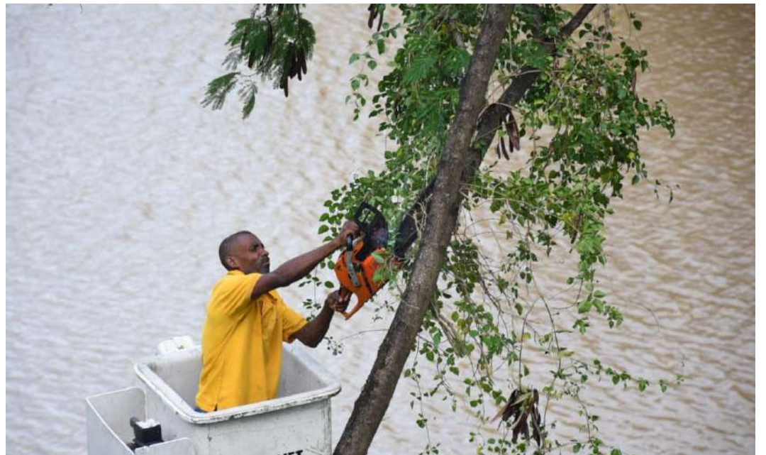
Obrero del ASDE retira árbol derribado por tormenta Fred.
