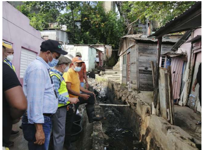
Alcalde Manuel Jiménez observa cañada durante desalojos preventivos en zonas vulnerables.
