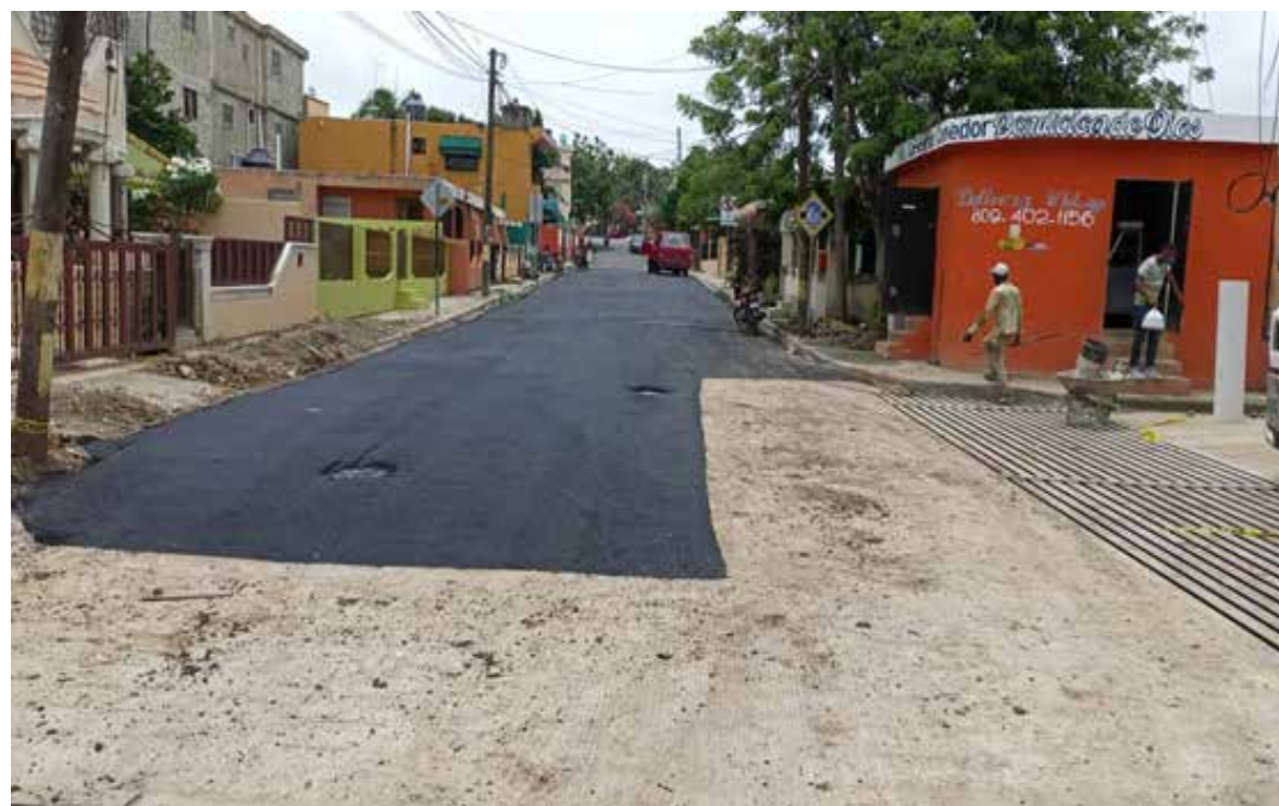
064/2019-CANALETA EN LA CALLE FELIPE ALFAU, TRINITARIOS II
