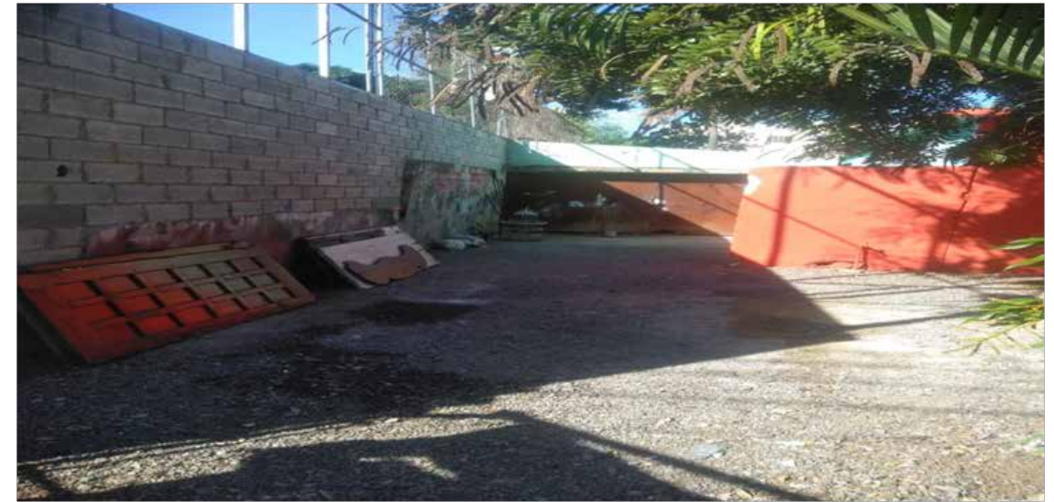
Esta inspección fue Realizadas en la calle Mayagüez número 92, del Ensanche Ozama.
