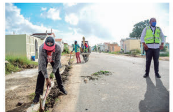
Ingeniero Héctor Garibaldi supervisa los trabajos que realiza el ASDE.
