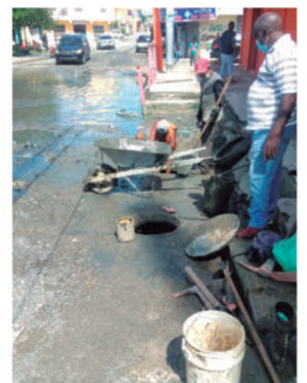
Limpieza de pozo filtrante.
