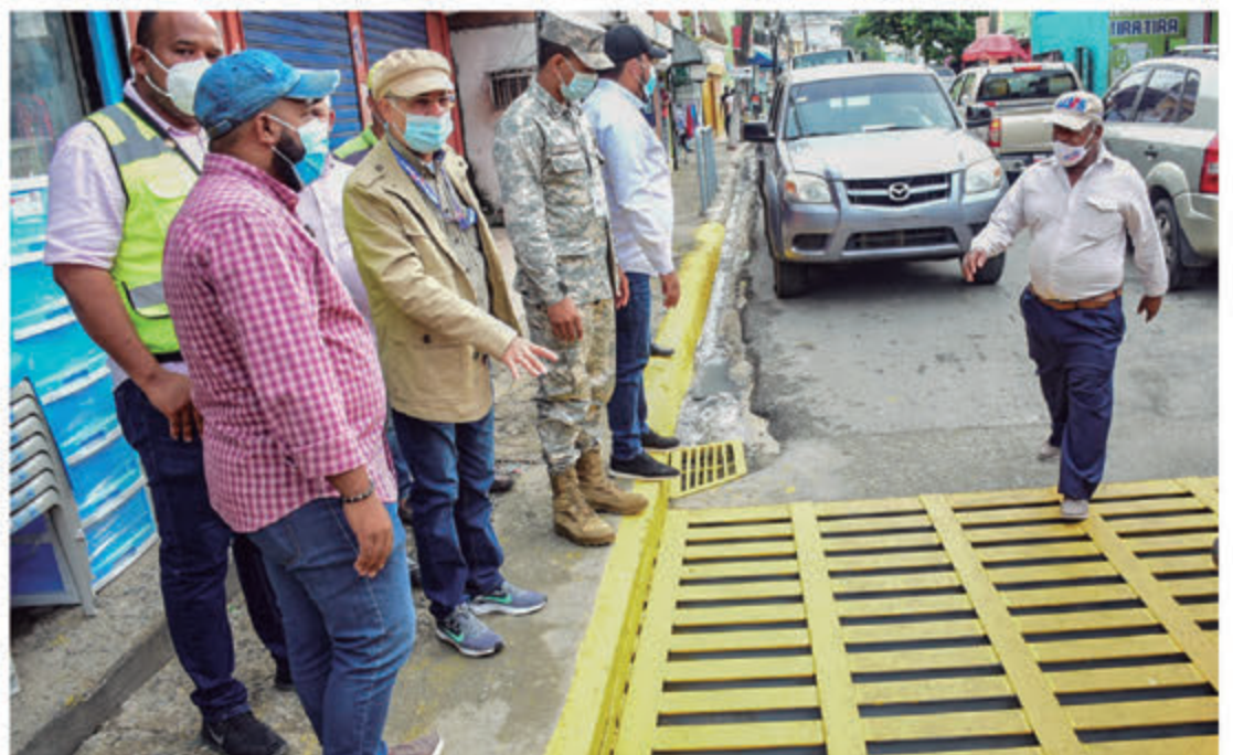
Canaleta remozada por el ASDE, en la Avenida presidente Hugo Chávez, antigua prolongación Venezuela, en Los Tres Brazos.
