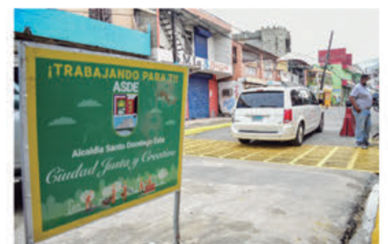
Canaleta lista para ser transitada.
