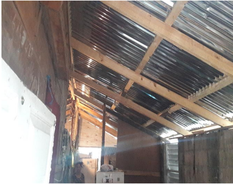
Reparación de vivienda en el barrio San Antonio Los Mina Norte.
